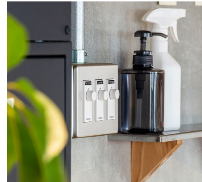
2FのCCコントローラー。バルコニーやラウンジなどゾーンごとの音量調節を行う。
