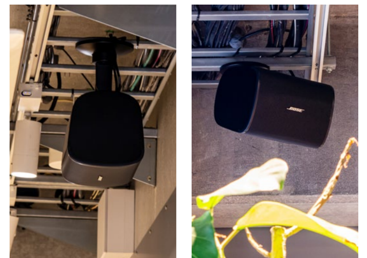
別売の天井吊りブラケットCMBS2を使って、躯体に固定されたDM5SE。
